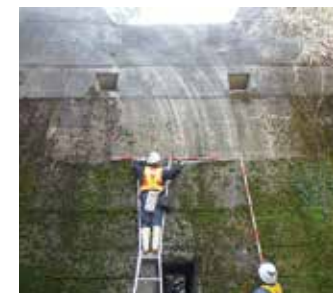
砂防施設点検
