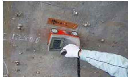
RCLレーダー非破壊検査
