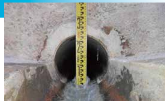
既設管の更生
