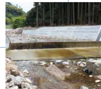
渓流保全工(床固工)設計
