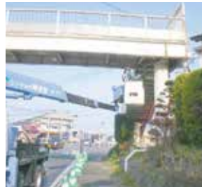
横断歩道橋の点検
