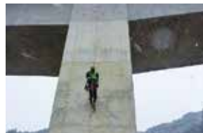
高橋脚の点検
