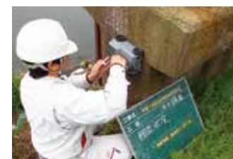
河川構造物点検
